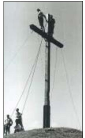
Die Seilverspannungen werden montiert.
