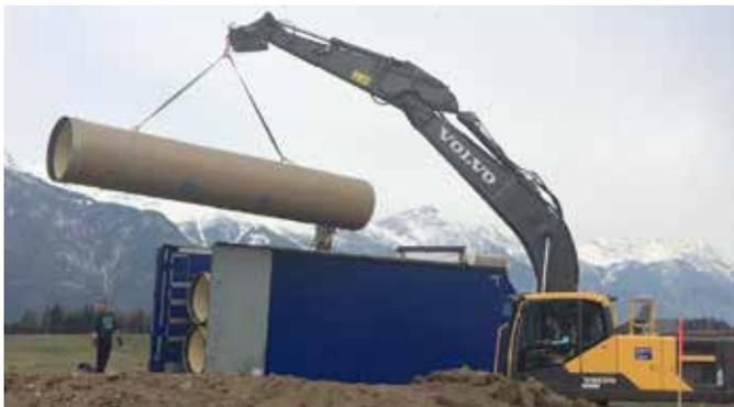
*Kanalrohr Durchmesser 1100 mm, aus glasfaserverstärktem Kunststoff mit einer Lebensdauer von 70-100 Jahren*
