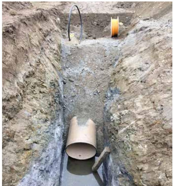
*Grabungsabschnitt Mühlleiten – Pestsäule: auf dem Bild erkennbar der Fels, den es zu bearbeiten galt links oben: die Mitverlegung einer Wasserleitung um einen Ringschluss mit der Gewerbezone herzustellen rechts oben: die Mitverlegung der Breitband-Leerverrohrung*
